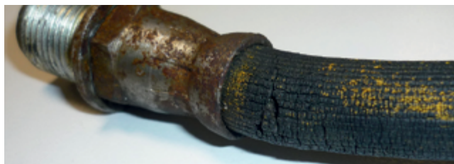
Zkorodovaná brzdová hadice
